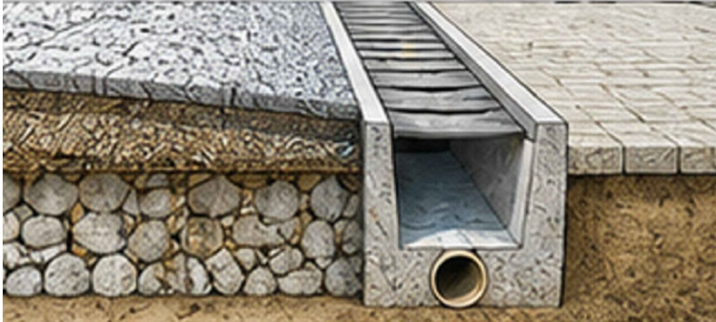
Влаштування дренажних лотків уздовж доріжок, водоприймальних колодязів та дренажних труб для відведення дощових і талих вод
