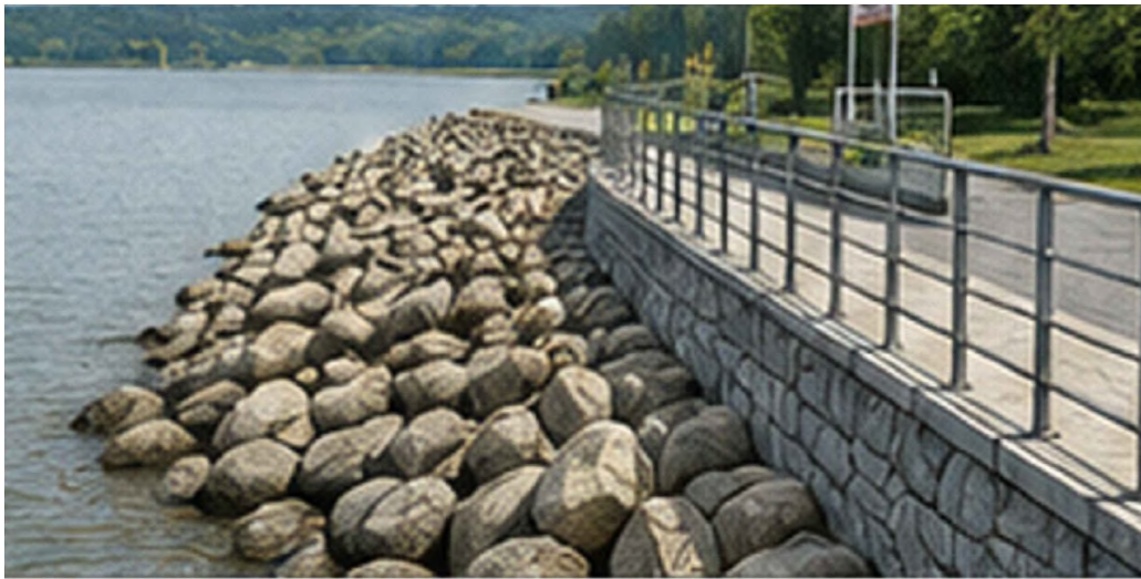
Влаштування камяної набережної (габіонів та натурального каменя) для захисту берега від розмиву хвилями
