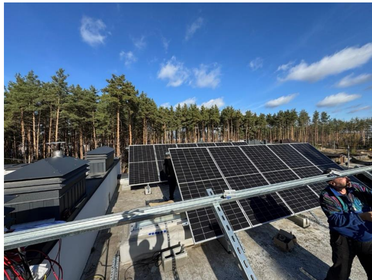
Рис. 2 - Процес монтажу панелей на плоскій покрівлі.
