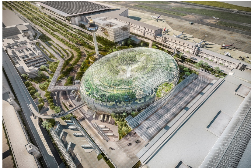
Рис. 2.3.8. Вигляд зверху аеропорту Jewel Changi в Сінгапурі [62].
