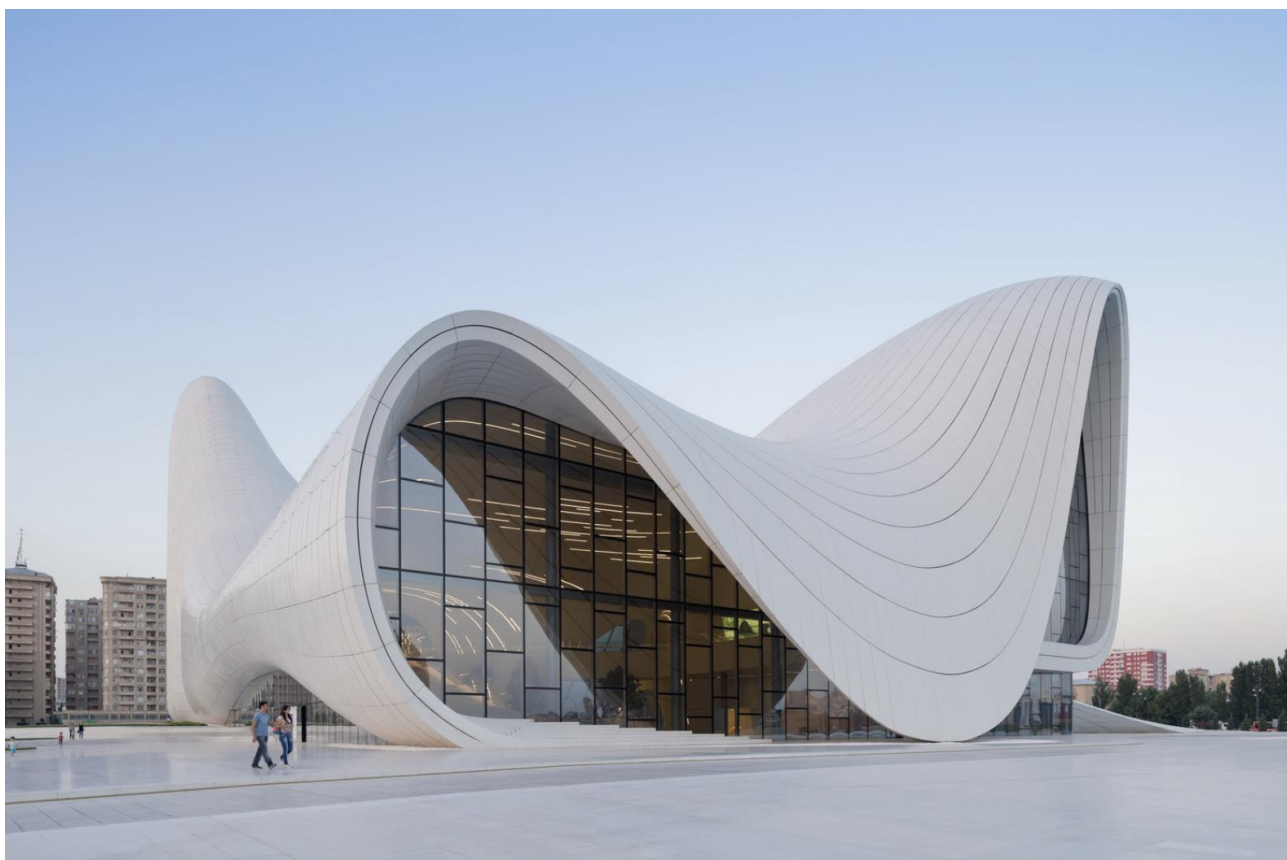
Рис. 2.2.1. Фасад Heydar Aliyev Center [4]
