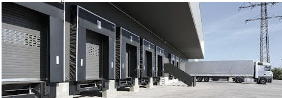
Рис. 3. Сучасне технологічне обладнання для облаштування закладів торгівлі а – підземні сміттєзбірні контейнери; б – розвантажувальні стиковочні шлюзи
