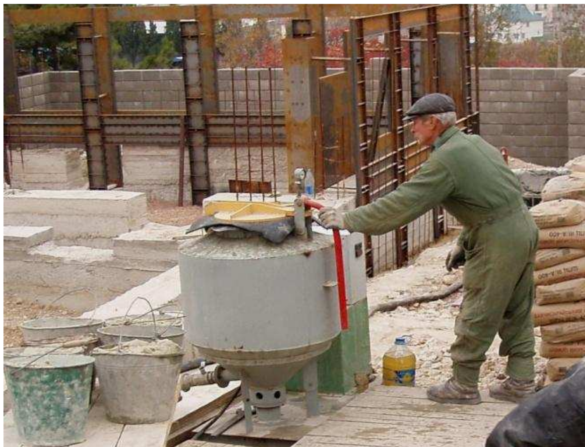
Рис. 1. Смесительная установка СПБУ-4 для производства пенобетона
