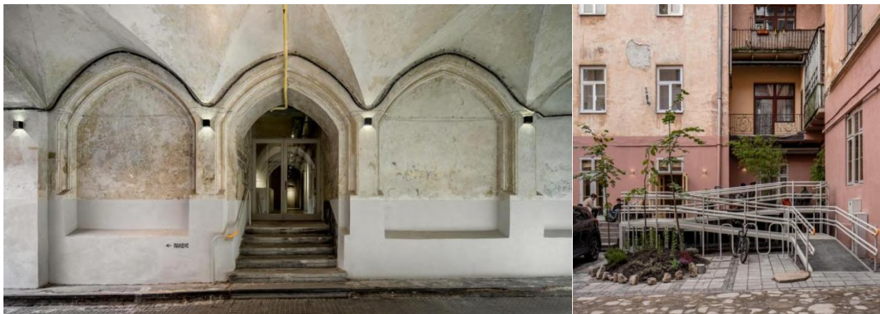
Рис. 2.11. Зовнішній вигляд будівлі: а) - головний вхід; б) - вхід з внутрішнього двору [25].
