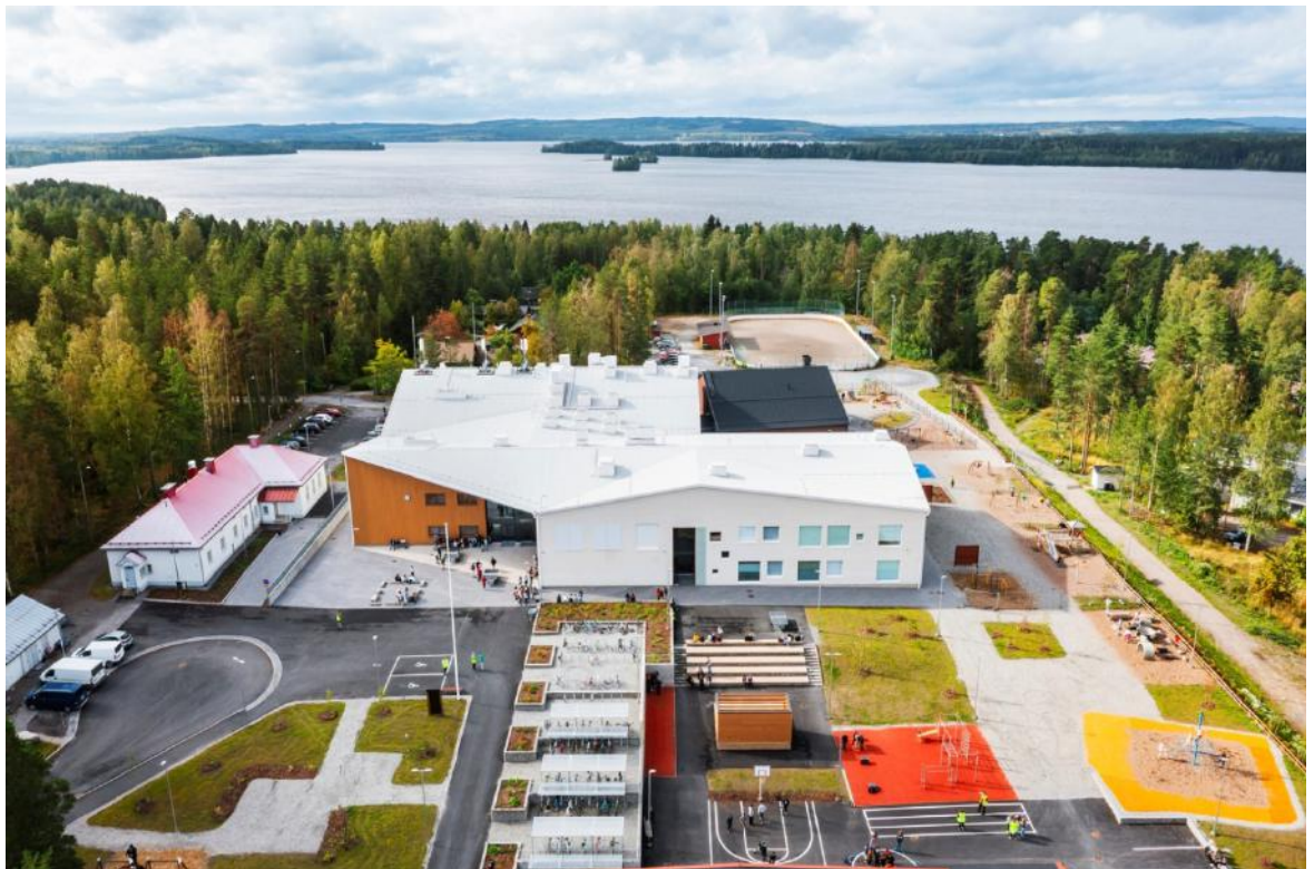
Рис. 1.3.3. Шкільний центр в Ханкасалм, Фінляндія; Архітектор: бюро Olla Architecture; 2020, [58]
