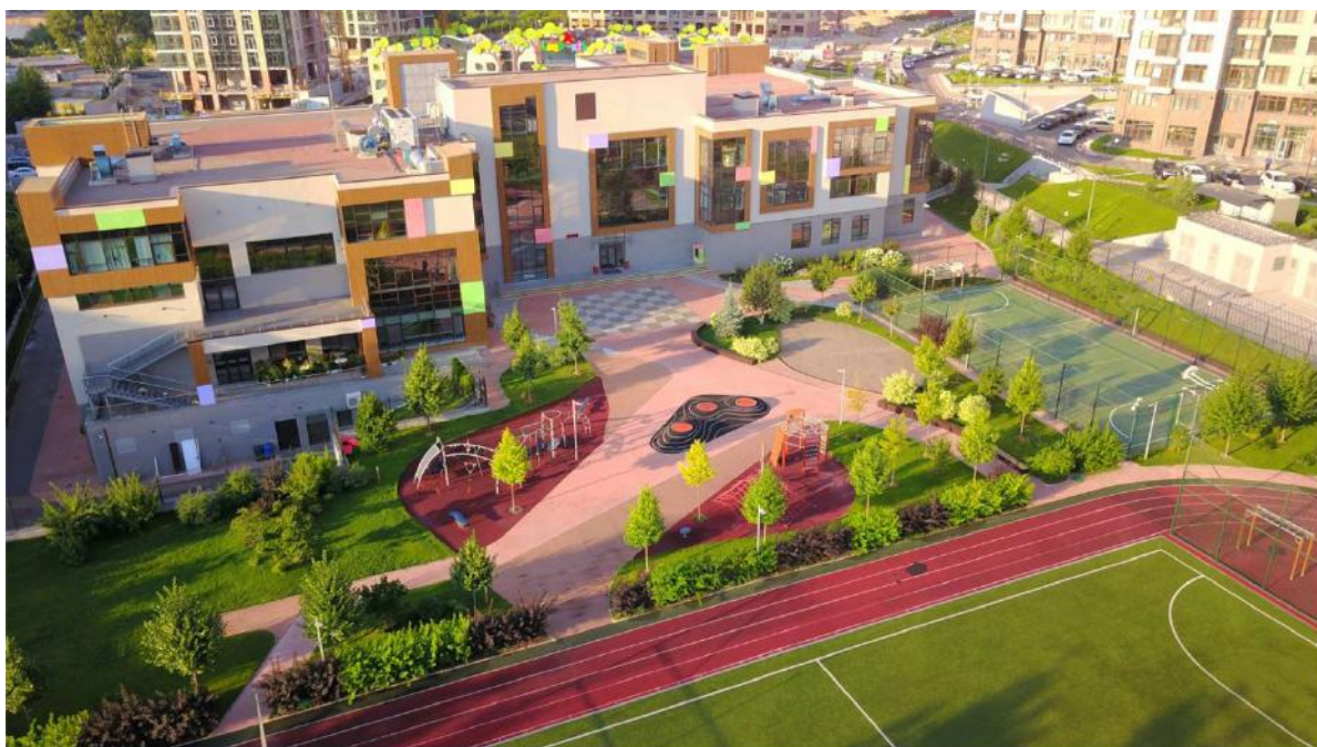
Рис.1.2.7. «Новопечерська школа» в м. Києві; архітектор: Kotsiuba, 2014 рік. [22]
