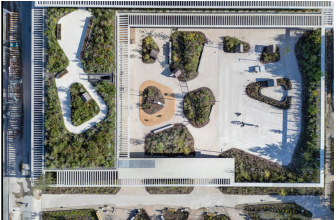
Рис.1.3.12. Вид зверху на Louise Michel School Complex, Загреб, Франція; Архітектори: Мар'ян Хессамфар та Джо Веронс, 2024, [64]
