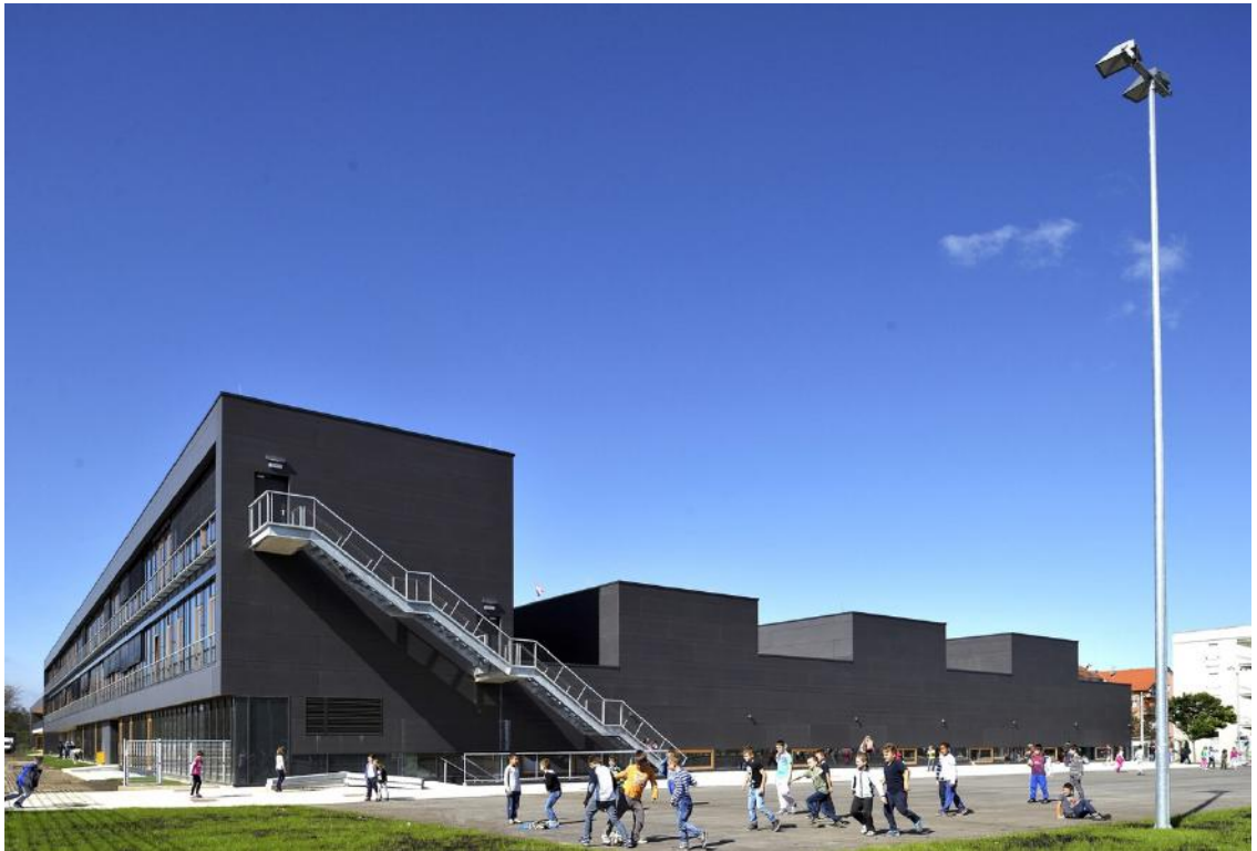
Рис.1.3.14. Загальний вигляд Educational Complex Kajzerica, Загреб, Хорватія; Архітектори: Sangrad + AVP, 2014, [59]
