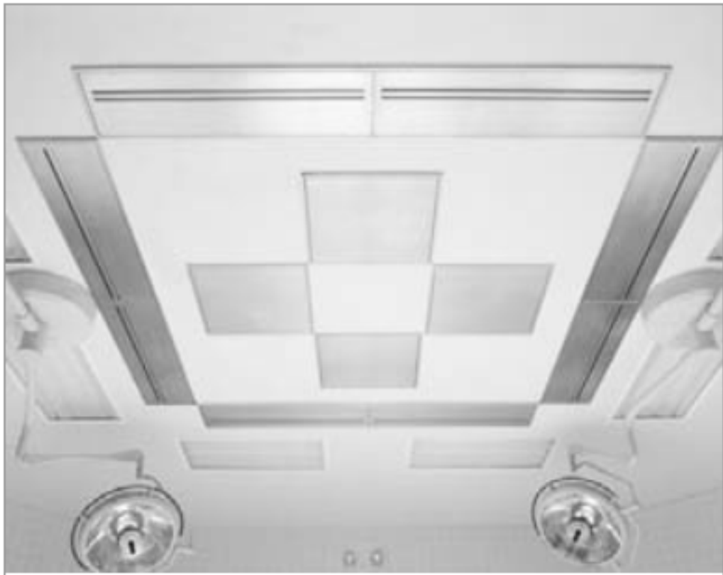
Рис.1.2. Схема пов. завіси
