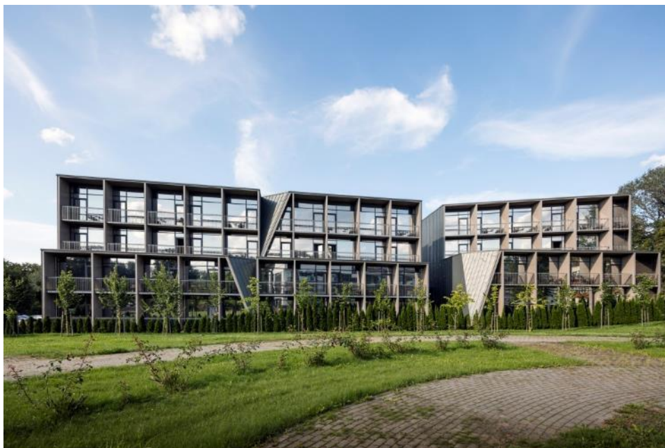
Рис. 2.1. Загальний вид на готель.
