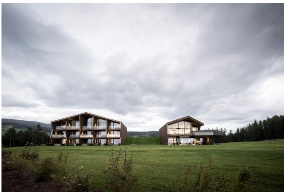
Рис 2.6 Загальний вид на готель
