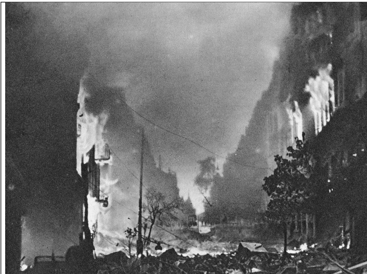
Рис. 1.2.5 До 1944 року після Варшавського повстання райони Старого міста, Повіслє, Середмістя, Волі були майже повністю зруйновані
