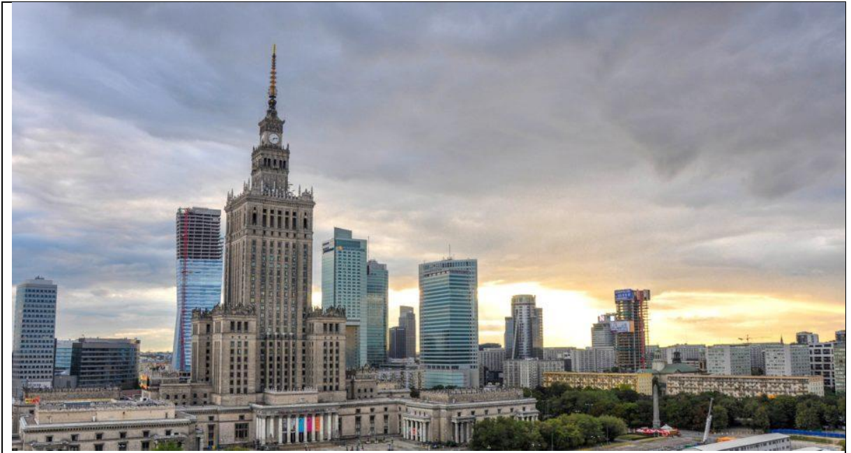
Рис. 1.2.9 Будівництво Палацу культури та науки у Варшаві завершилося в 1955 році. Фото: Unsplash
