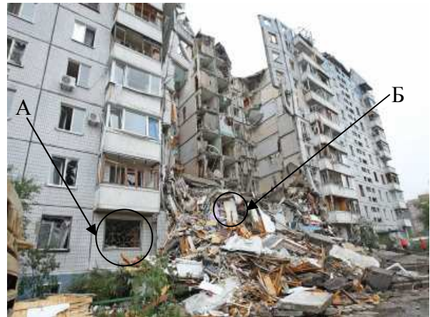
Рис. 2. Зруйнована будівля і завал, розміри уламків якого визначаються
