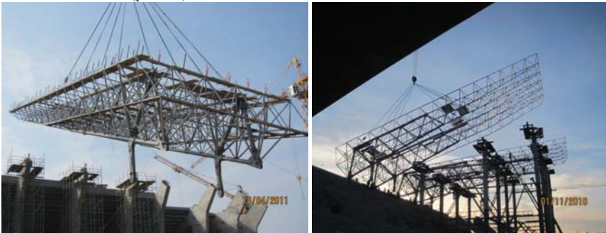
Рис. 4. Монтаж секцій покриття
