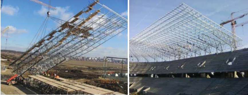
Рис. 8. Секції даху і готовий дах
