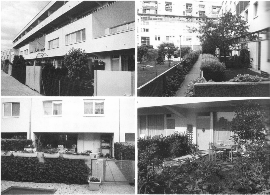
Рис. 2 Приквартирні дворики в зоні індивідуальних входів до квартир [2].
