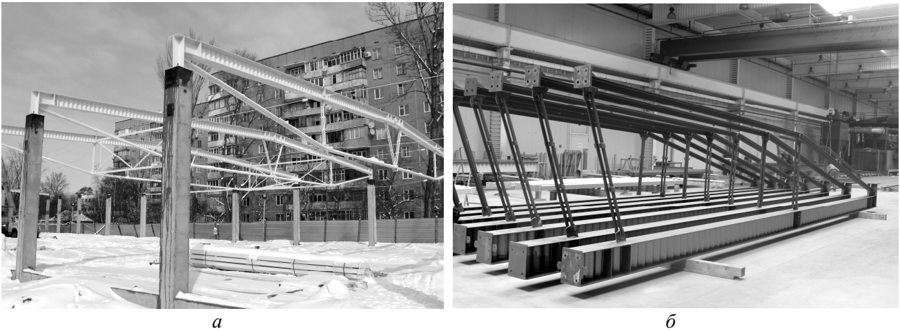
Рис. 2. Малоелементні кроквяні ферми: а – змонтовані ферми покриття; б – ферми в процесі виготовлення (фото М.В. Лазнюка)
