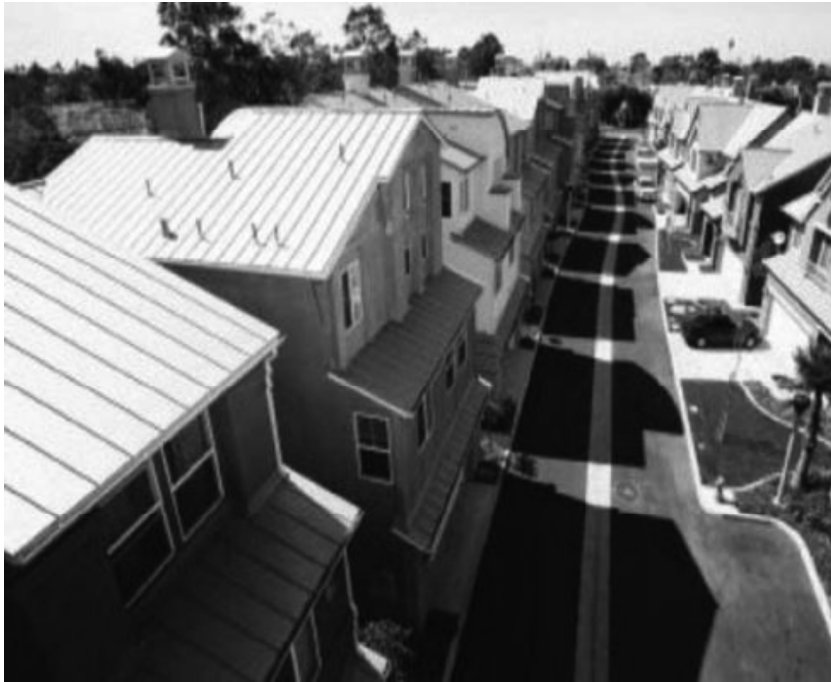
Рис. 1. Приклад «Холодного» («білого») покриття.
