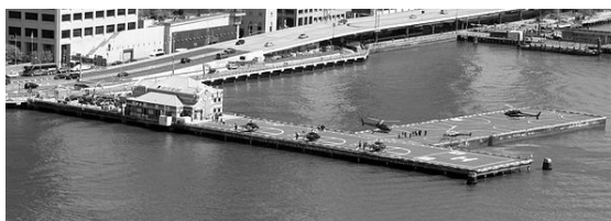
Рис.2 Вертольотна станція Манхеттена в Нью-Йорку (США)
