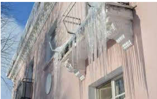
Рис.7. Навантаження на балконну плиту під час льодіння Fig.7. Anti-icing loading onto the balcony slab
