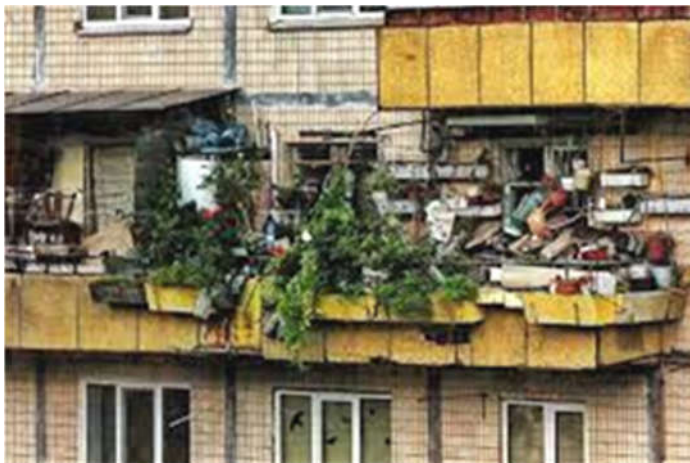
Рис.8. Екстремальні навантаження на балконні плити під час експлуатації
