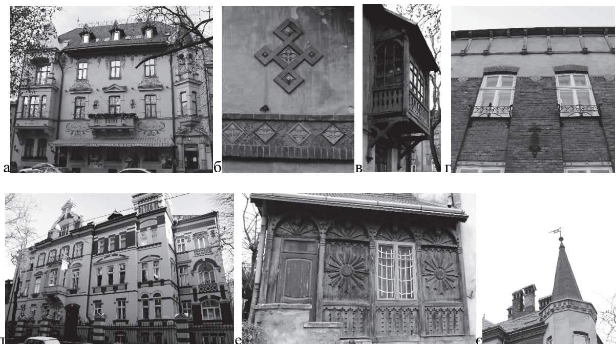
Рис. 5. Принцип “новаторства” виявлена в розписах, у використанні майоліки, дерева, металу, у відкритій цегляній кладці складеній в різні узори: а) вул. Маланюка, 7; б) вул. У. Самчука, 5; в) вул. Нечуя-Левицького, 20 (балкон дерев’яний з різьбленими кронштейнами); г) вул. Котляревська, 41 (жардиньєрки); д) вул. Лук’яновича, 9-11; е) вул. Мельника, 7 (різьблена веранда); є) вул. Ожешко, 11 (флюгер).
