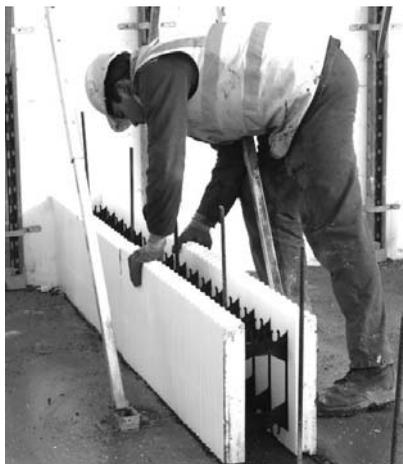
Рис. 1. Общий вид стандартного опалубочного пенополистирольного блока стен ярусного вида.
