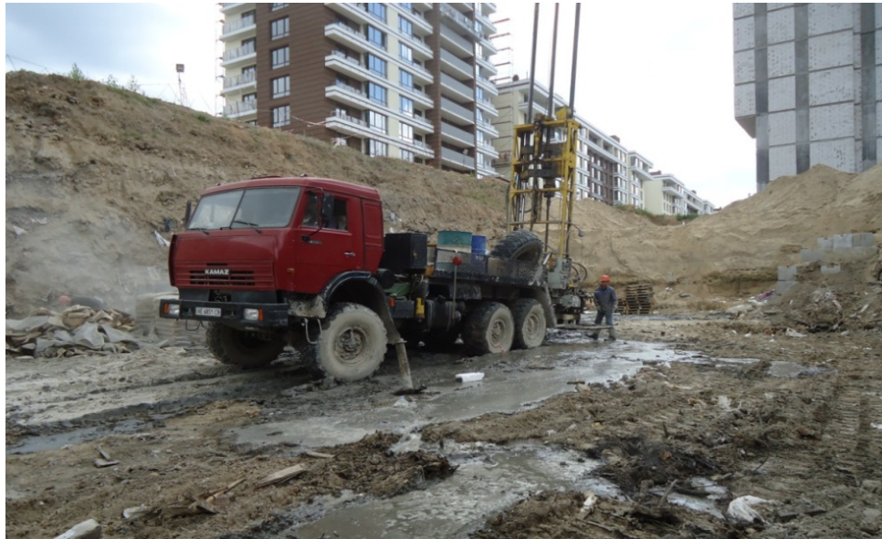
Рисунок 17 – Виконання робіт по закріпленню основи ґрунтоцементними елементами за допомогою бурозмішувальної технології
