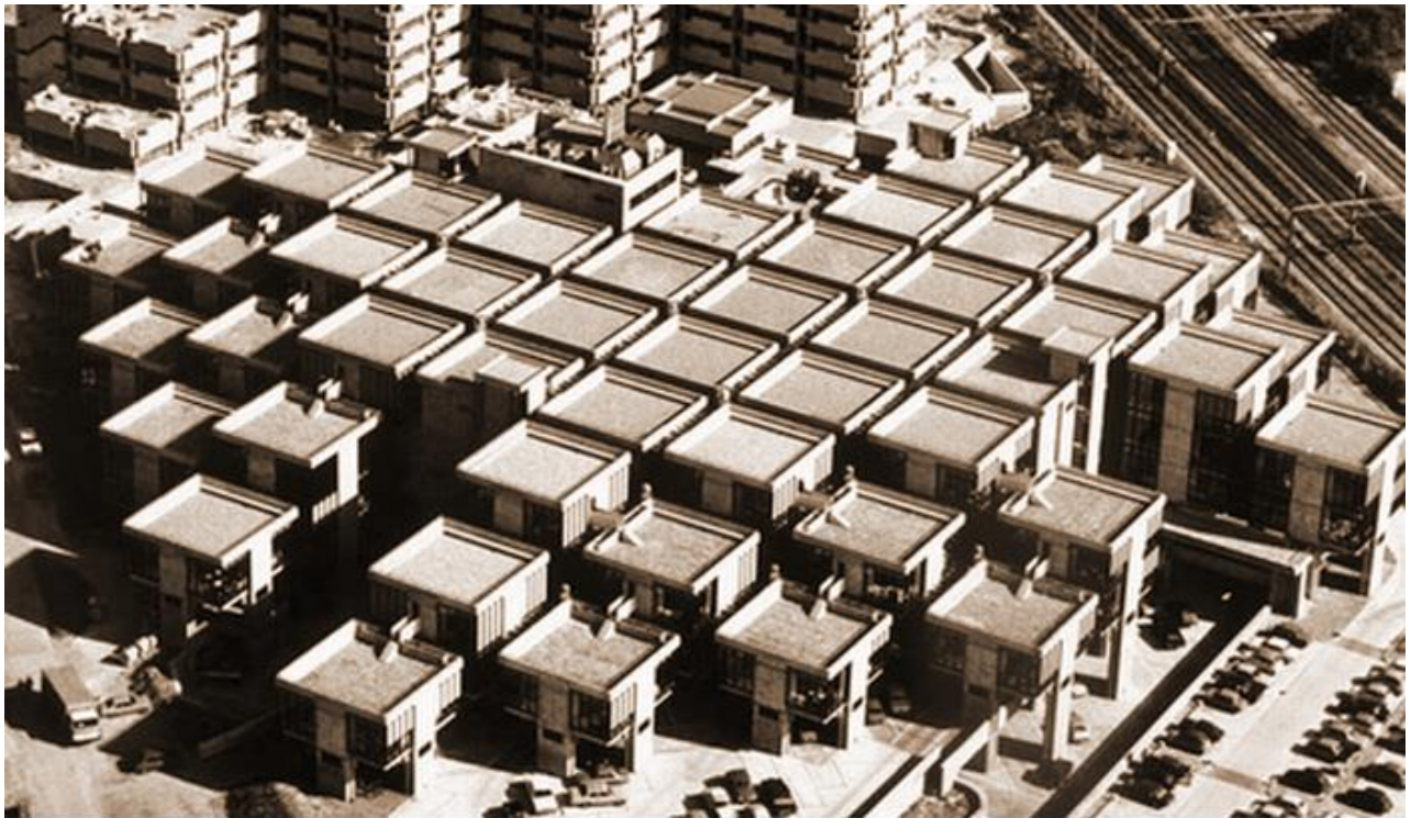
Рис. 2. Приклади інтегральної структури громадського комплексу на базі блок-модульної системи.
