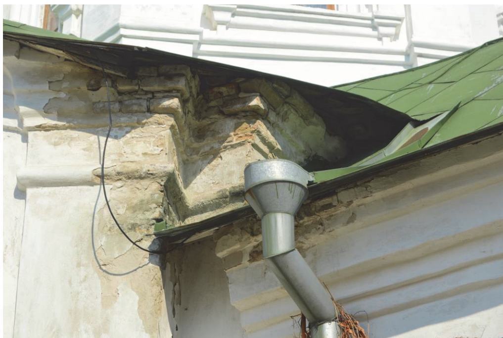
рис. 3. Руйнування кладки та тиньку на західному фасаді
