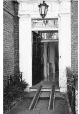
Рис.6. Знімний пандус в церкві Сент-Джеймс. Колчестер, портативного пандусу Великобританія
