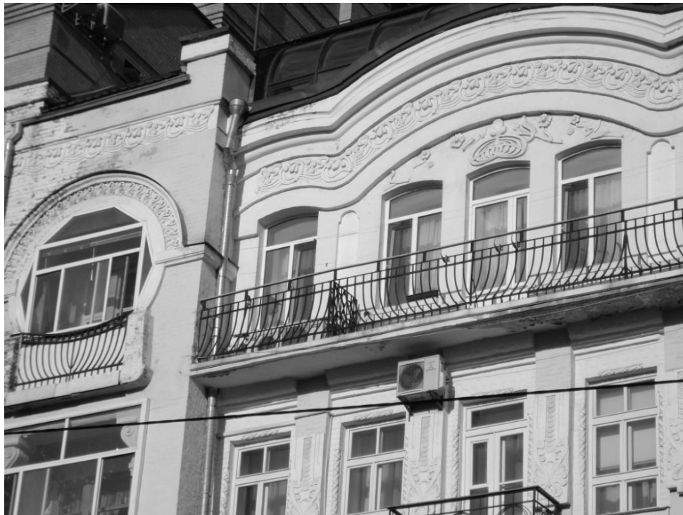
Рис.1. Фрагмент фасаду будинку на вул.Володимирській,81-а (Київ, стиль модерн)
