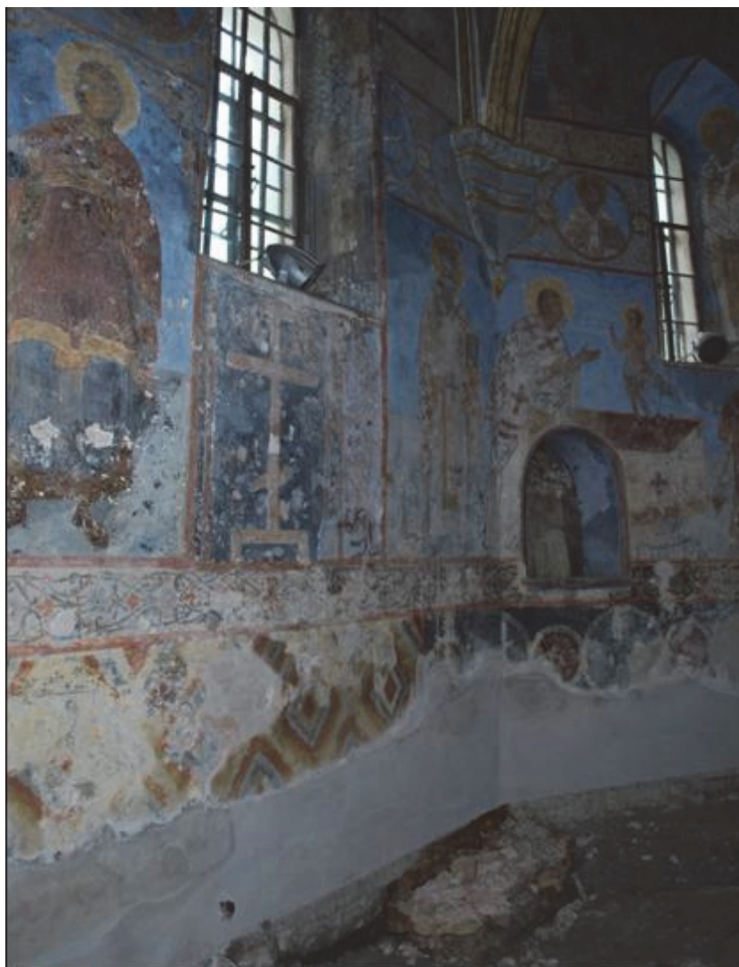
Рис. 1. Пошкодження живопису, утворення солей по верхній кромці сануючої штукатурки.
