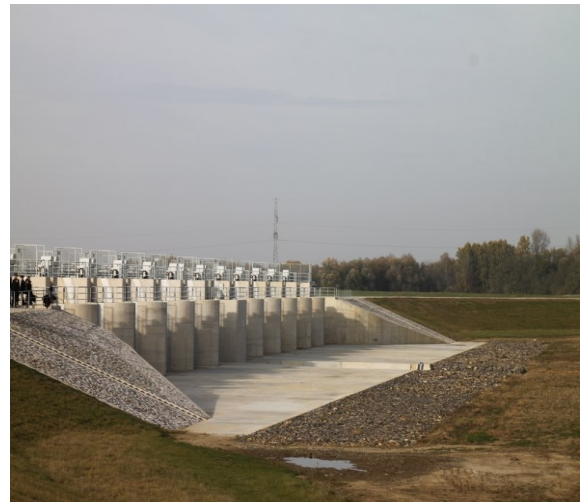
Фото 2. Водозабірна споруда найбільшого протипаводкового акумулюючого польдера «Самош-Красна», Угорщина, 2014
