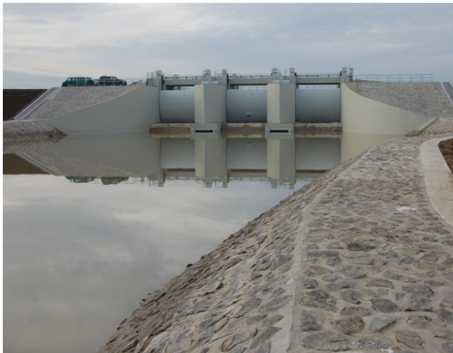
Фото 1. Водозабірна споруда протипаводкової акумулюючої ємкості «Циганд», Угорщина, 2008
